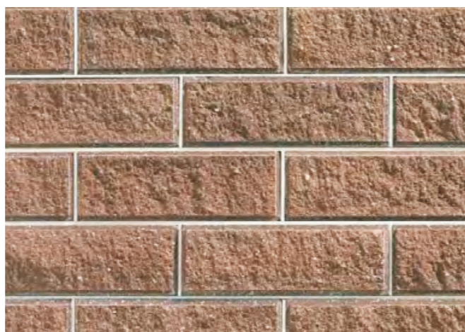
Укладка плитки с расшивкой
